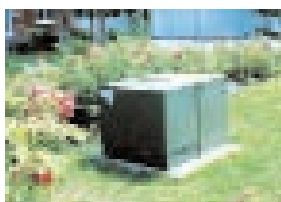
Transformateur sur socle.
